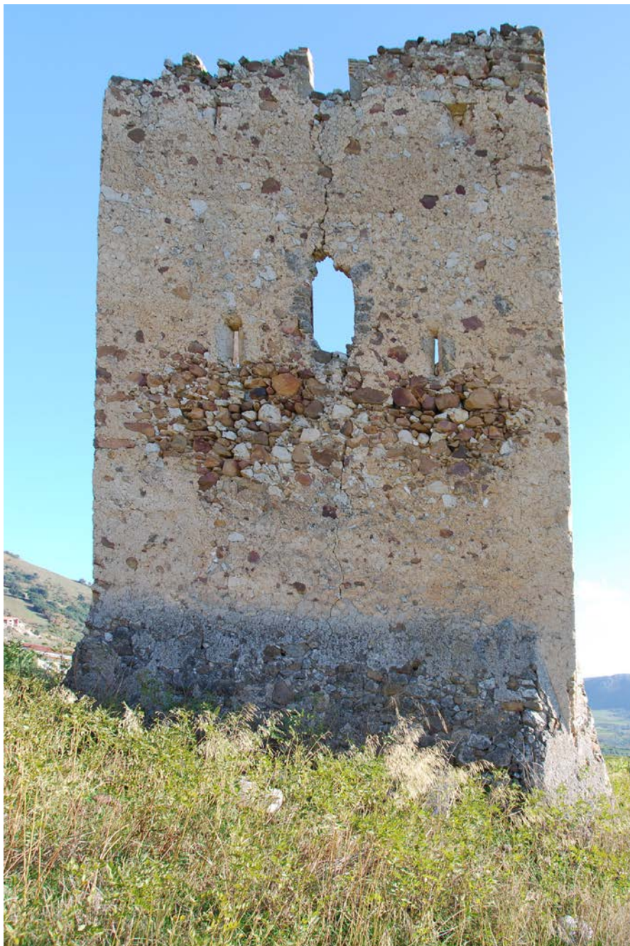
Fig. 32 - Il lato settentrionale della Torre di Catrini con le due finestre e le quattro feritorie.
