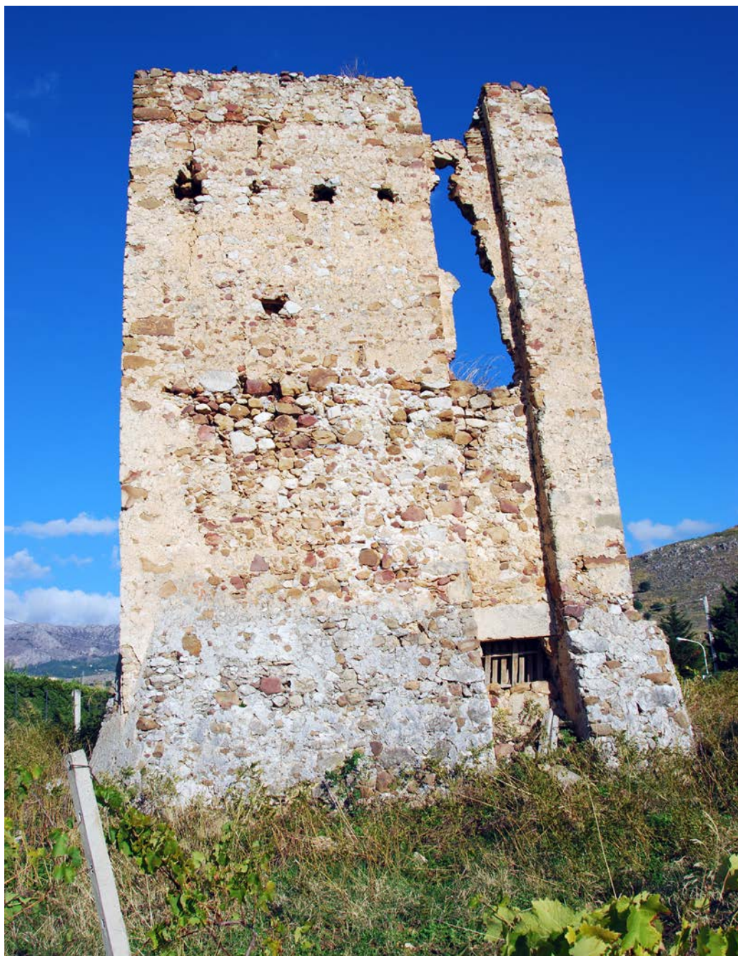
Fig. 23 - Il lato ovest della Torre di Catrini. In evidenza l'ingresso e la caditoia.
