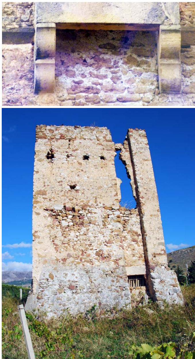
Fig. 15 - Sopra una bertesca-caditoia cinquecentesca, sotto lo stesso sistema realizzato nel XII secolo
