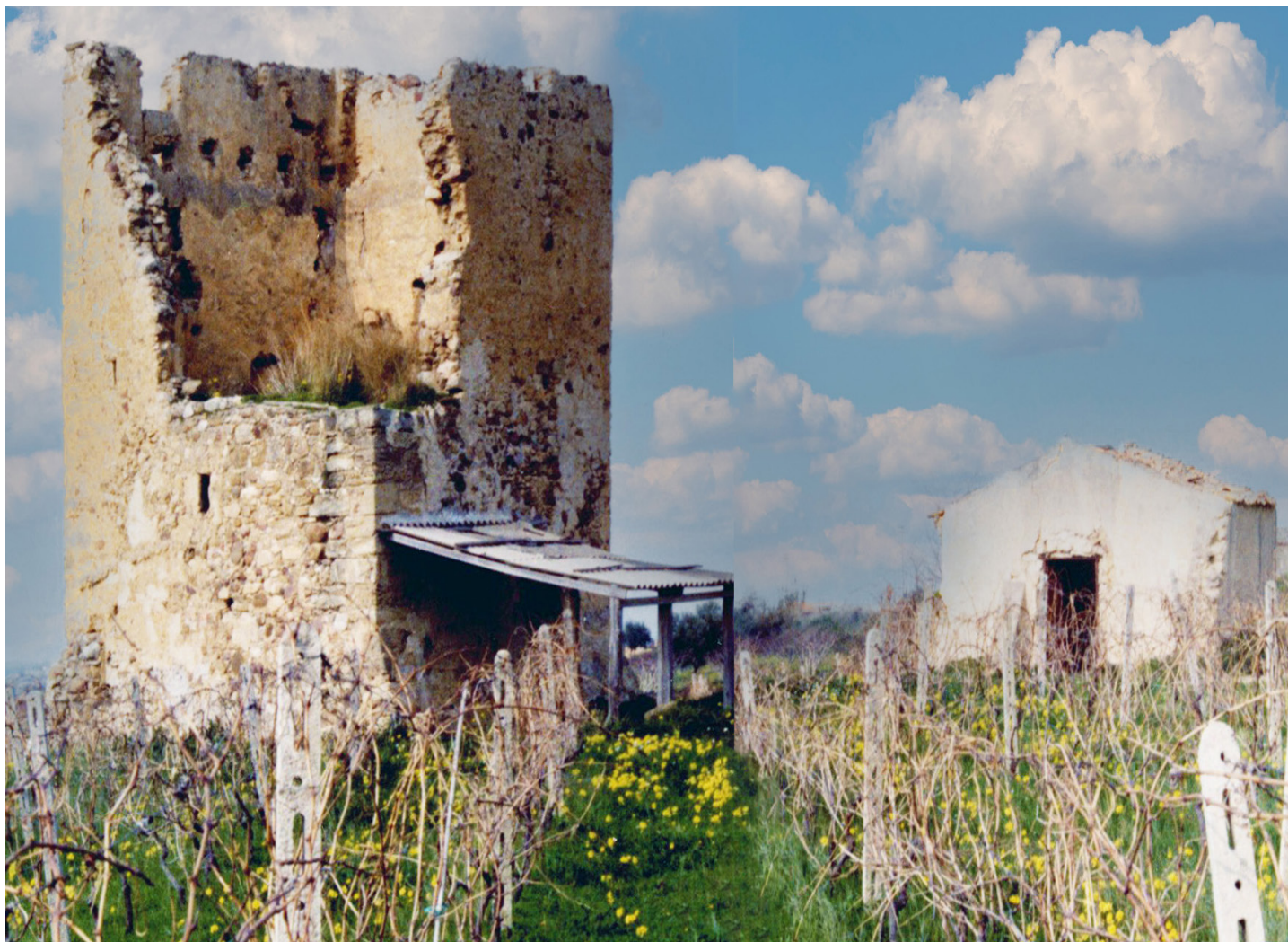
Fig. 29 - I lati sud ed est della Torre di Catrini. Si notano nel muro interno le tracce delle volte e quelle delle travi. In basso, una grossolana pennata e, sullo sfondo, la chiesetta caditoia una feritoia e appendici murarie.
