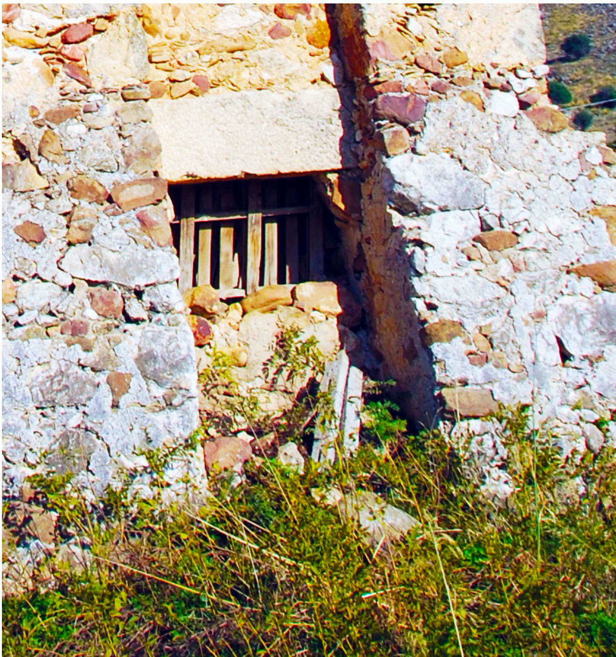
Fig. 25 -La porta d'ingresso originale della Torre di Catrini, oggi, trasformata in finestra, con la trabeazione.
