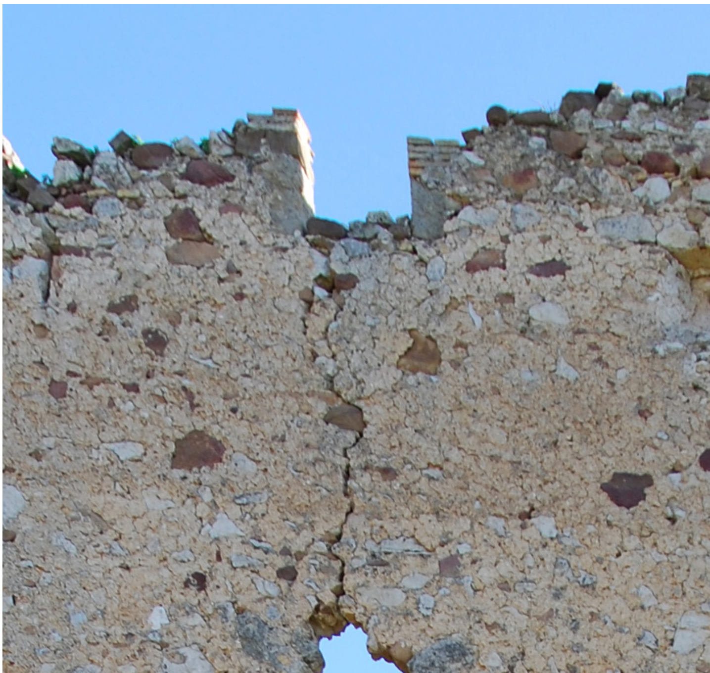
Fig. 21 - Particolare della finestra e delle feritoie del secondo piano sul lato nord della torre. . Essa dimostra che la torre doveva essere più alta
