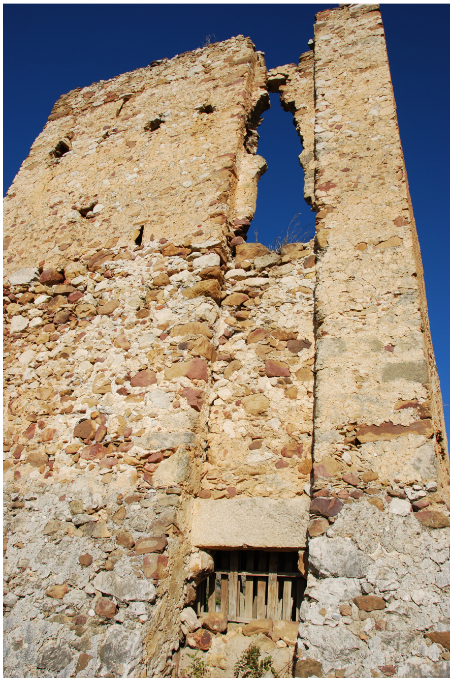
Fig. 24 - Il lato ovest della Torre di Catrini. In evidenza l'ingresso e la caditoia.
