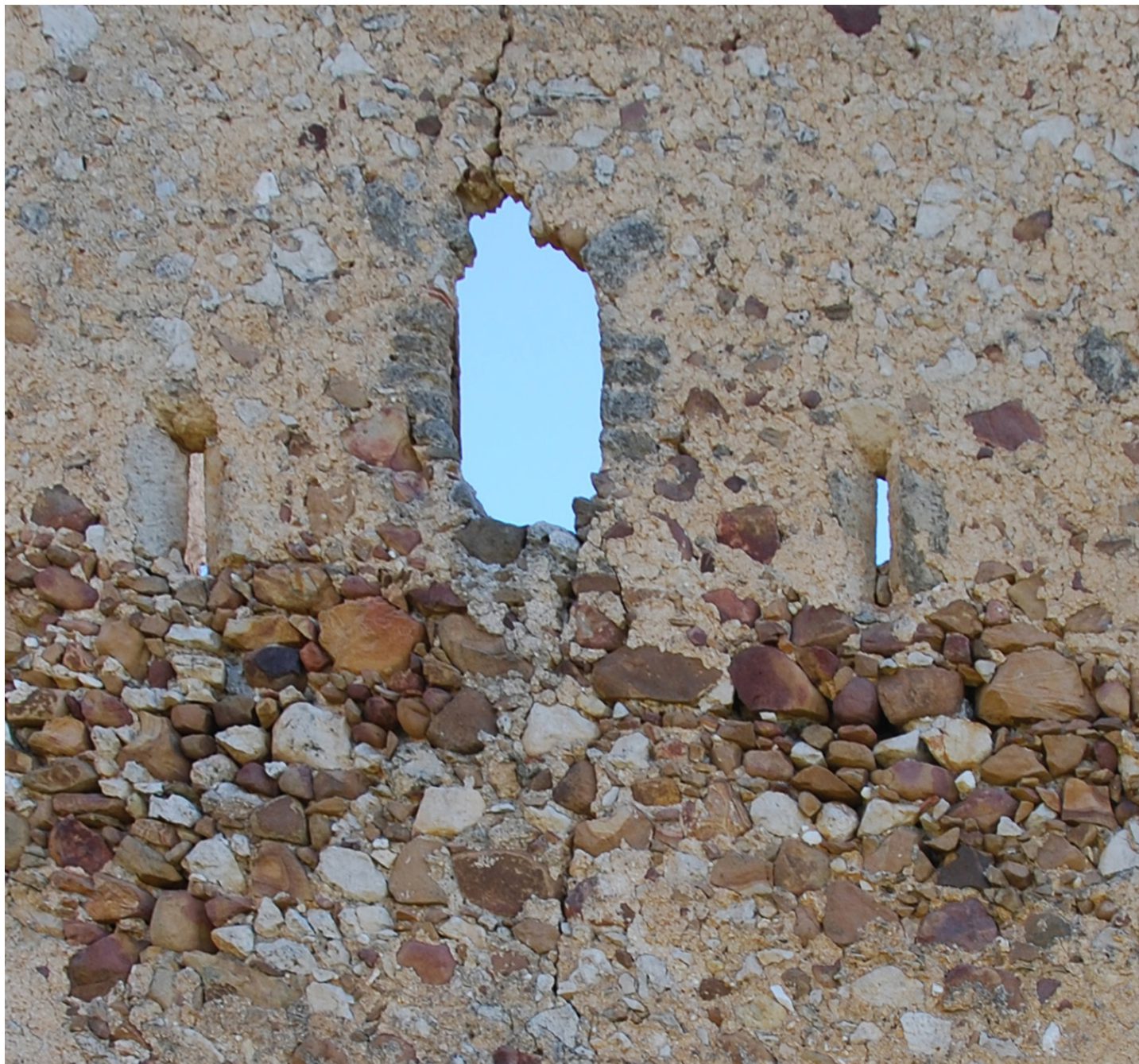
Fig. 20 - Particolare della finestra e delle feritoie del primo piano sul lato nord della torre.
